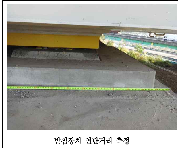
【사진 42.3.12】 교량받침장치 연단거리측정
