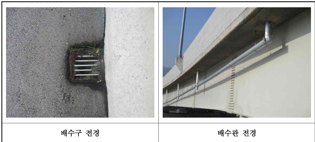
【사진 42.3.19】 배수시설 전경
