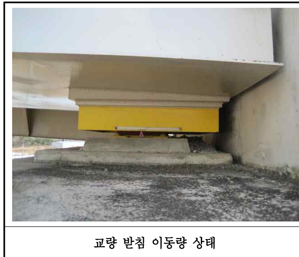
【사진 42.3.13】 교량받침 이동량 상태
