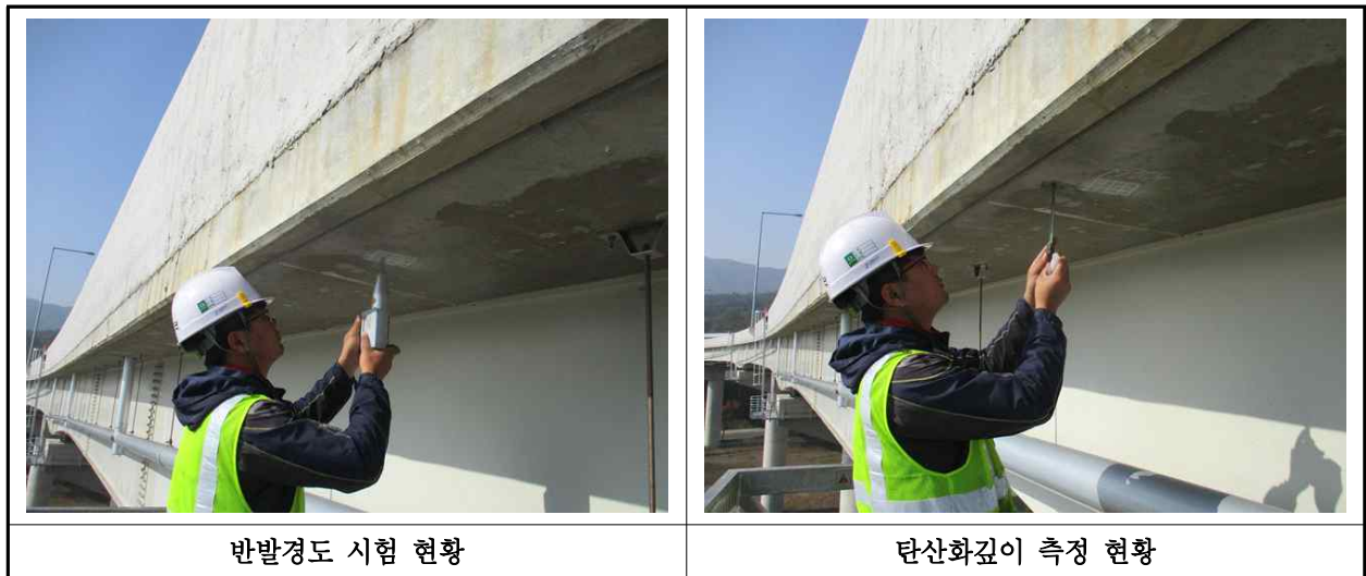
【사진 42.4.1】 콘크리트 내구성조사 현황
