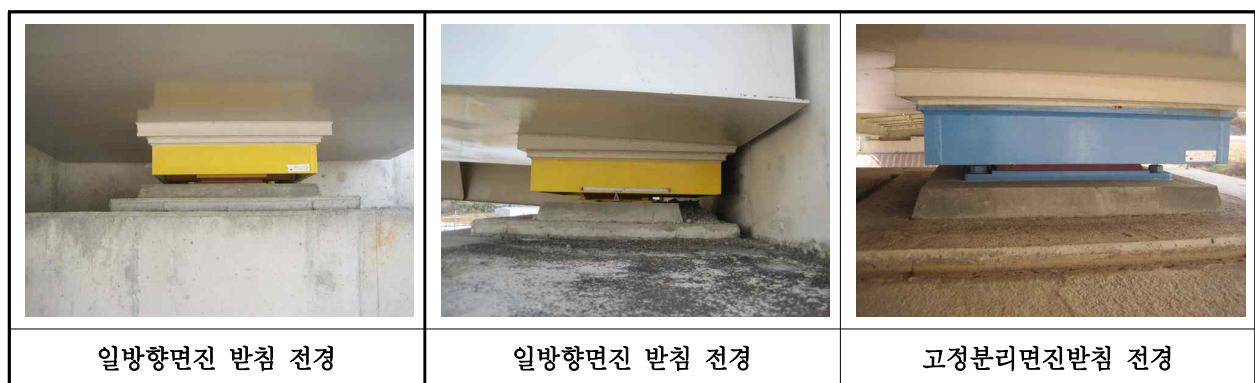
【사진 42.3.10】 교량받침 전경
