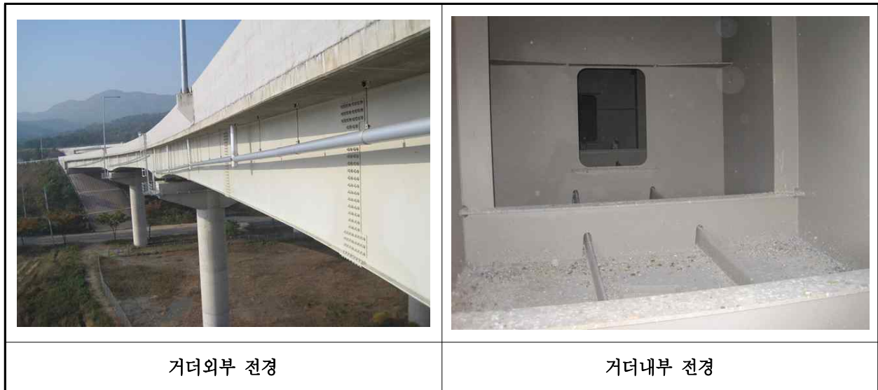
【사진 42.3.4】 거더 전경
