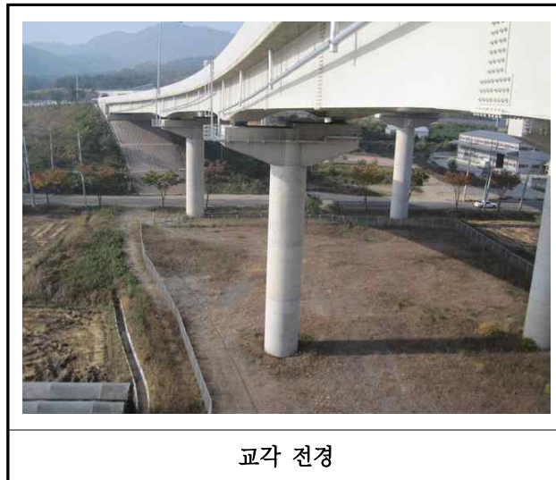
【사진 42.3.8】 교각 전경
